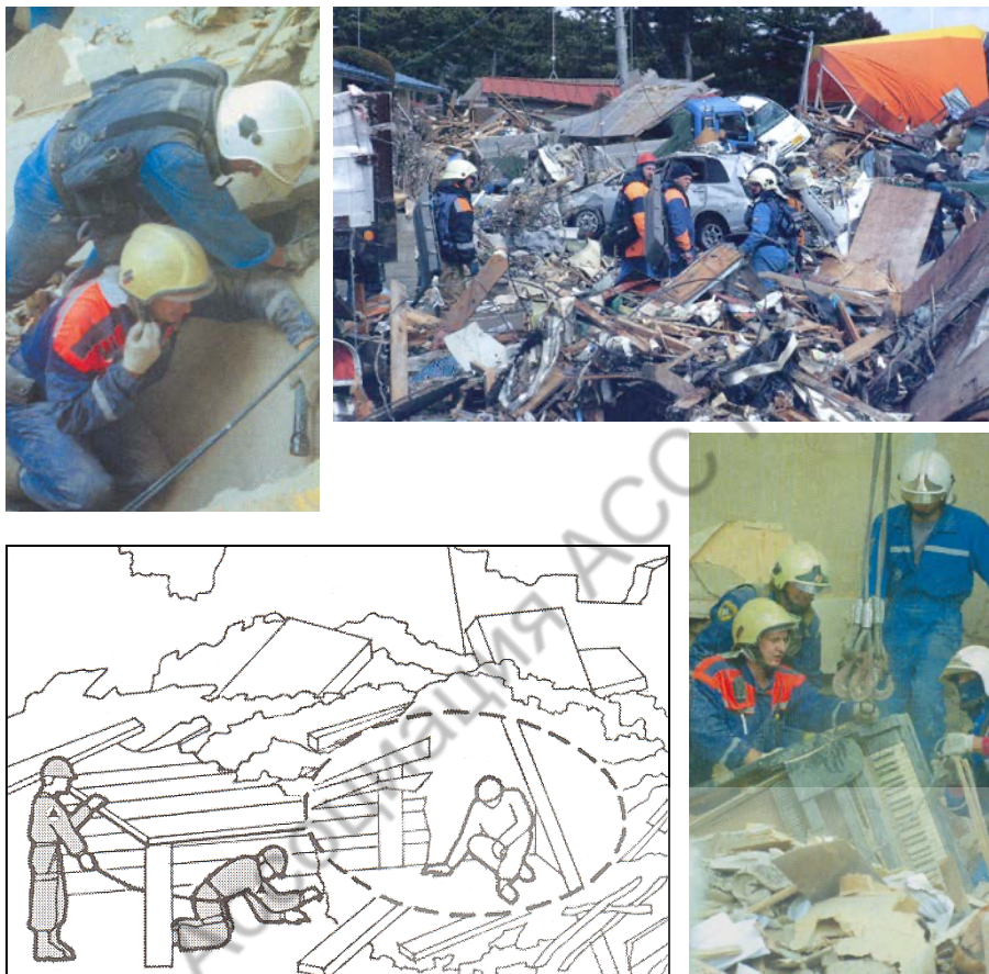
Рис. 73. Разборка завалов, устройство лаза в завале
