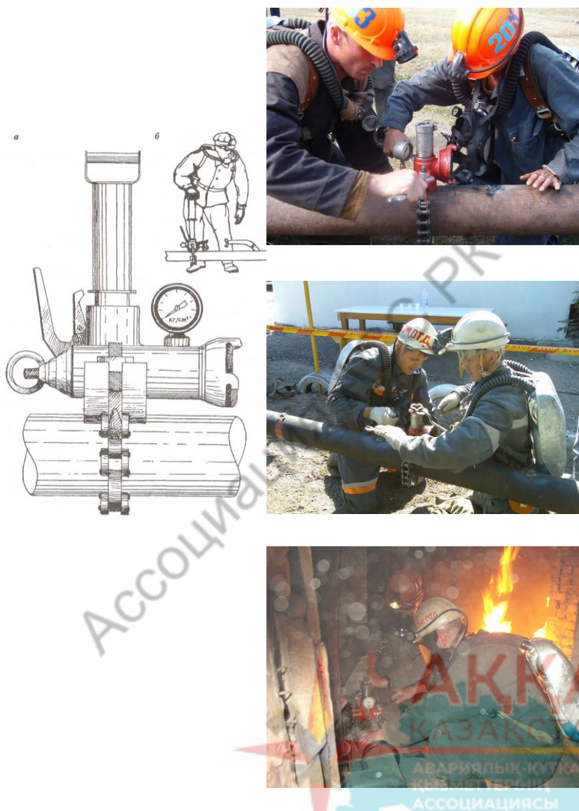
Рис. 83. Установка гидрант-пистолета на пожарном трубопроводе
