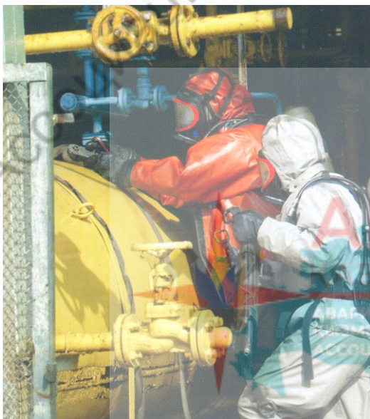
Рис.216. Аварийные работы на газопроводе
